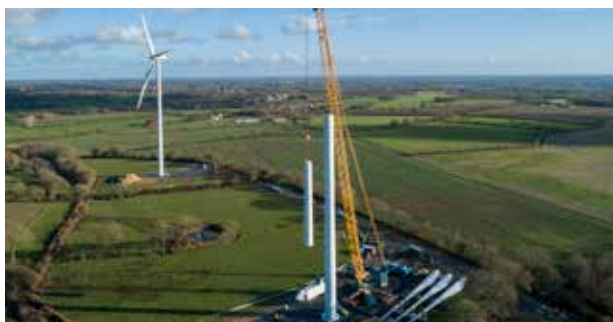
Montage d'un mât
